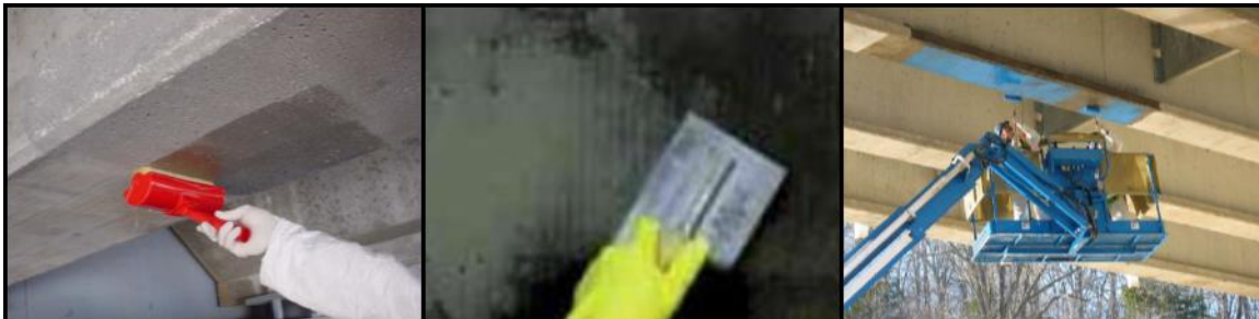
1. Application of primer
